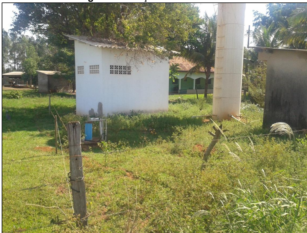
Figura 3.7- Poço do assentamento.
